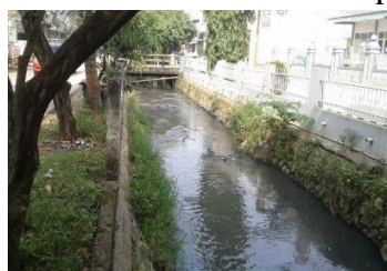
Channel at Bukit Tiara
